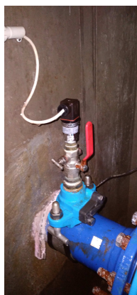
Obrázek 3.6: Snímač Danfos, navrtávka
