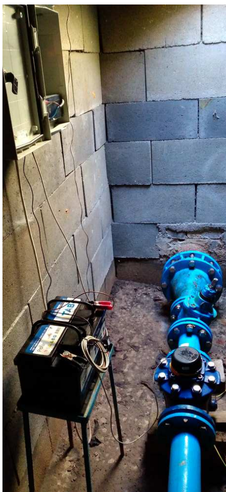
Obrázek D.1: Ukázka vodoměrné šachty U DPS
