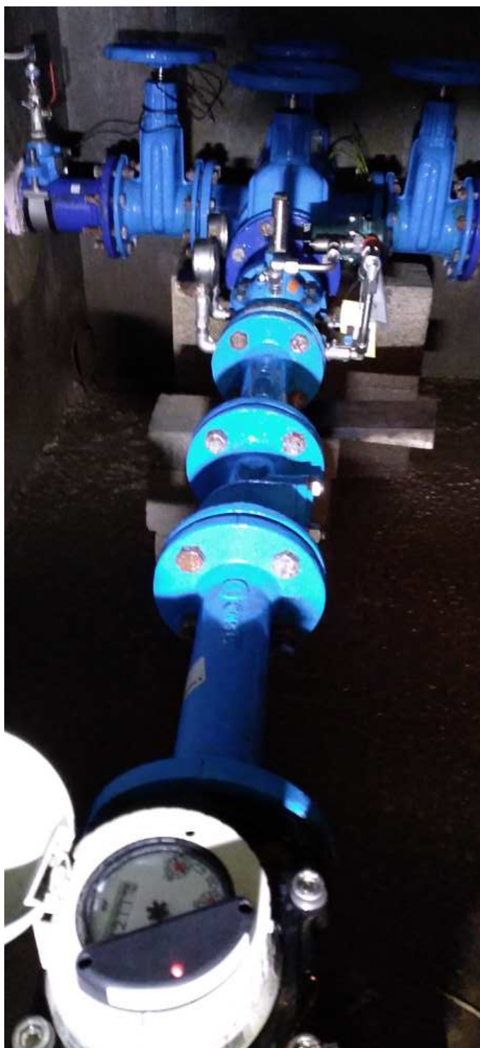
Obrázek D.4: Ukázka vodoměrné šachty U Zuzany
