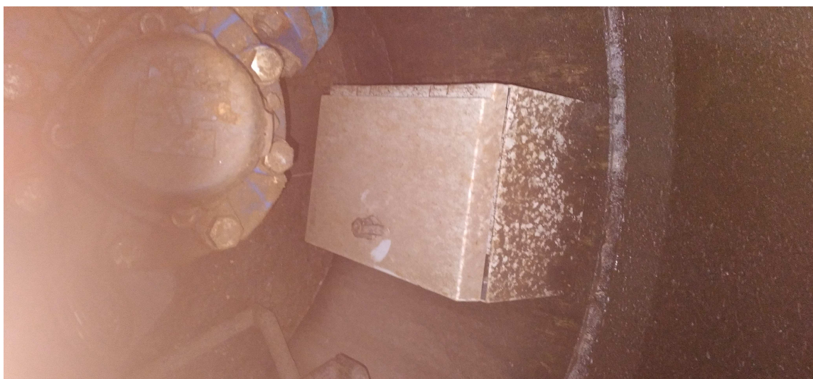
Obrázek 4.3: Vodoměrná šachta Písecká
