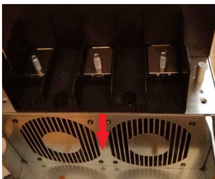
Obrázek 4.10: Výměna ventilátoru Neos
