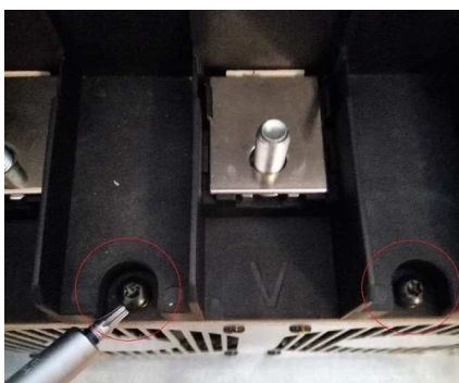
Obrázek 4.9: Výměna ventilátoru Neos: Torx T25
