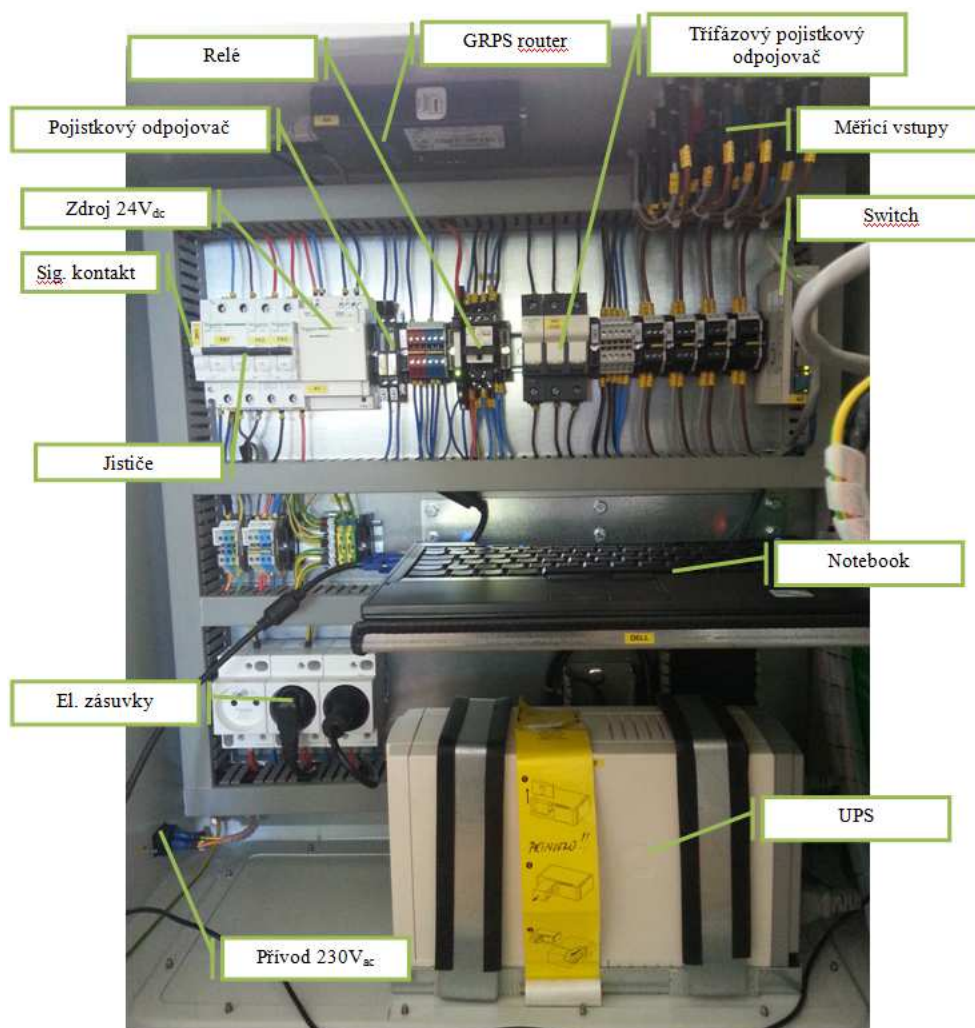
Obrázek E.1: Rozmístění komponentů v rozváděči
