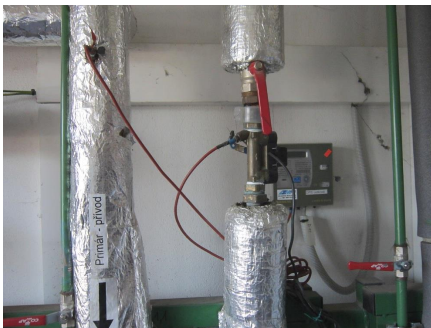
Obr. 15 Umístění měřiče tepla
