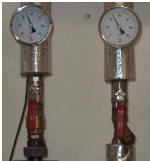
Obrázek 8: Bimetalové teploměry
