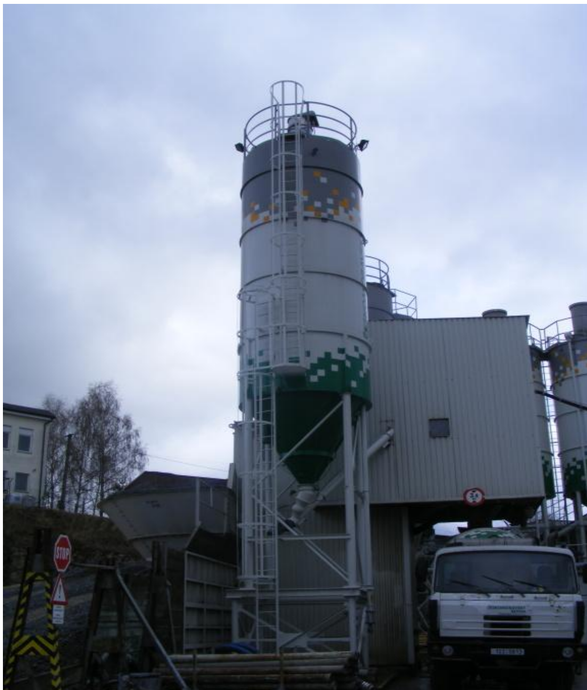
Foto 9.4: Cementové silo s příslušenstvím
