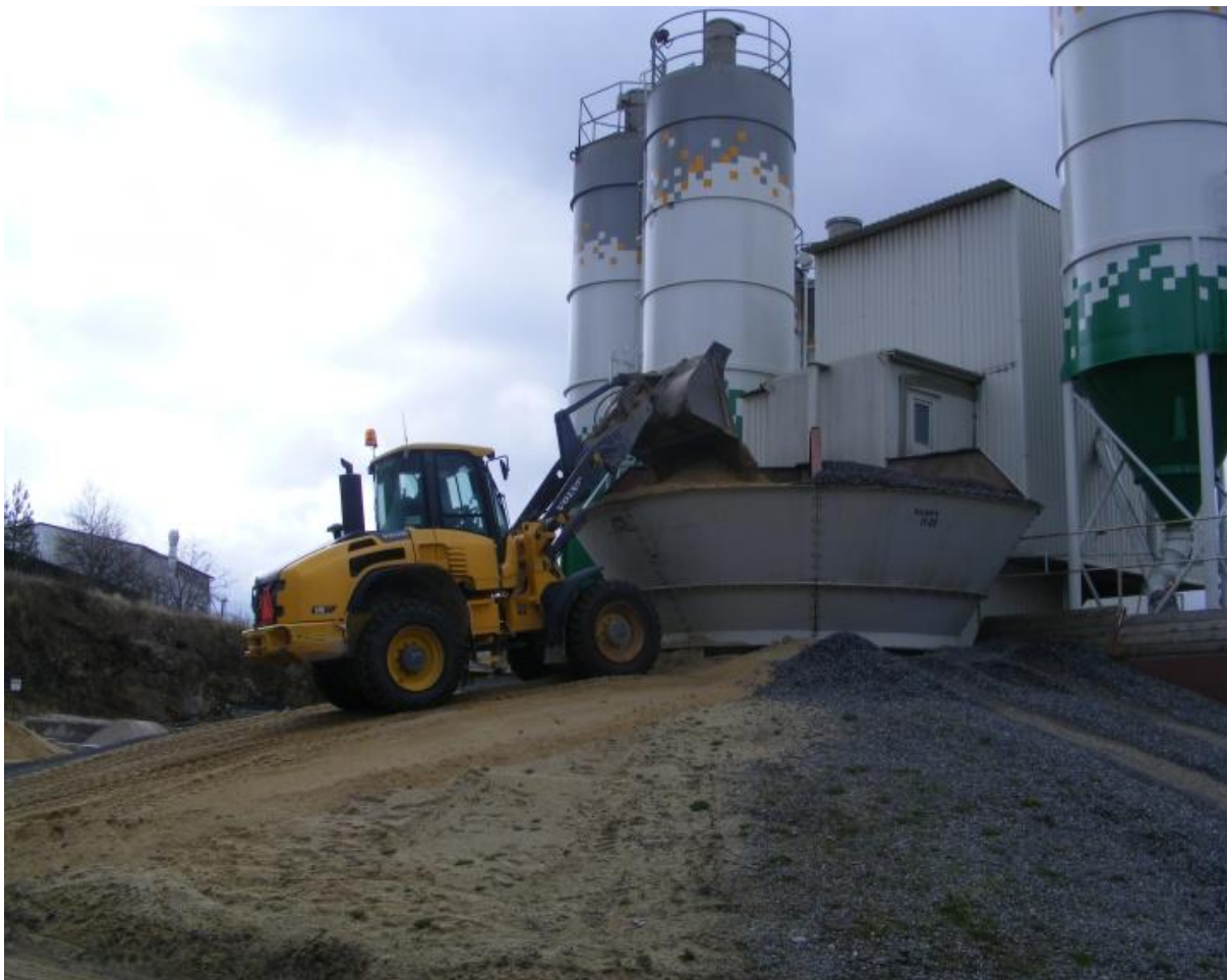
Foto 9.2: Kolvý čelní nakladač naváží kamenivo do vějířového zásobníku
