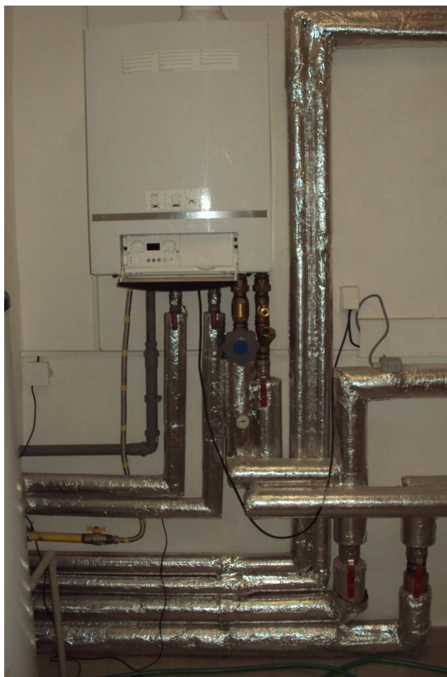
Obrázek 4: Osazený plynový kotel Buderus
