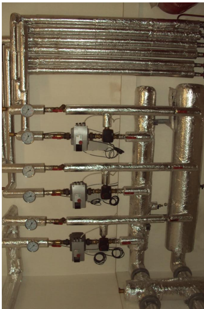
Obrázek 8: Sdružený rozdělovač RS Kombi
