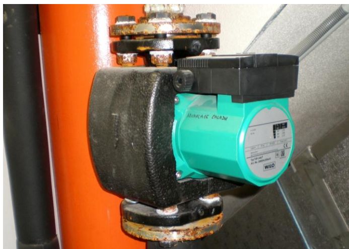
Obr. 15 Čerpadlo od firmy Wilo
