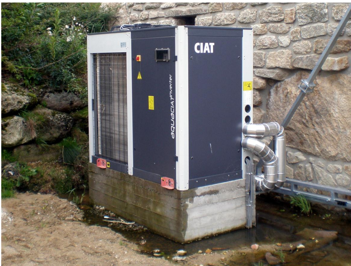
Obr. 9 Tepelné čerpadlo CIAT Aquaciat Grand Inverter IVDC 200 V
