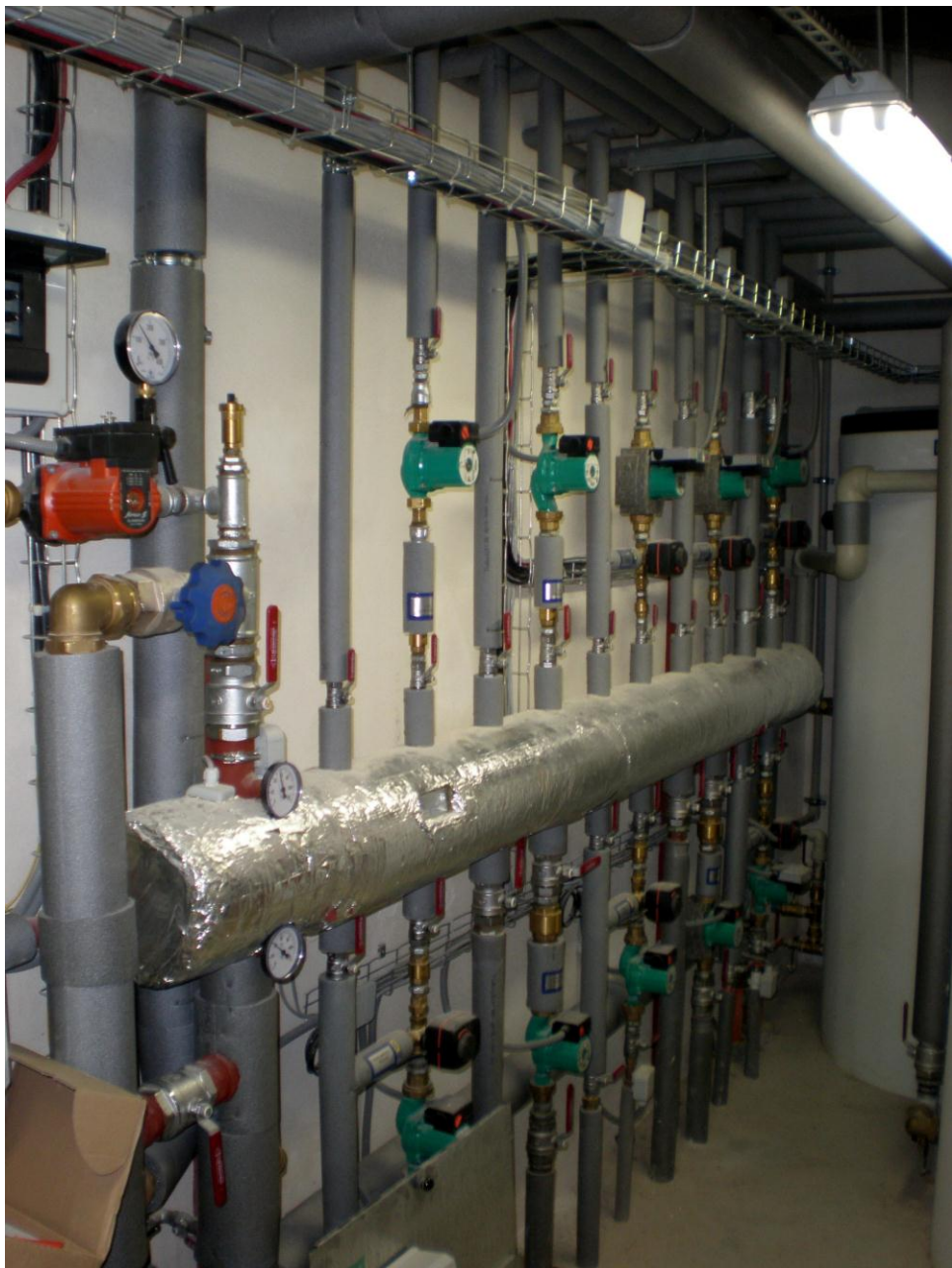
Příloha č. 22: Instalovaná čerpadla v kotelně ekofarmy
