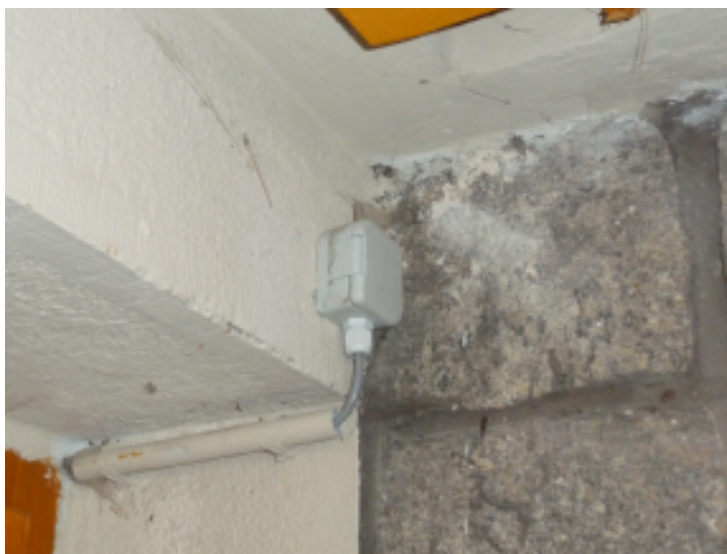
Obr. 15 Venkovní čidlo Ni-1000 umístěno tak, aby nebola na přímém slunci
