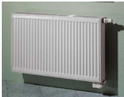
Obr. 6 Vytápění pod okny
