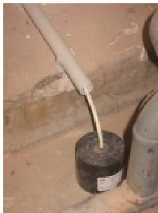
Obr. 9 Hladinové čidlo pro případ úniku kapaliny z otopného systému
