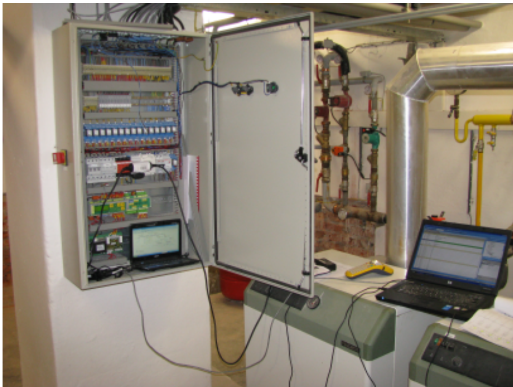
Obr. 10 Fotografie s instalace softwaru do systému po kontrole zapojení rovaděče.
